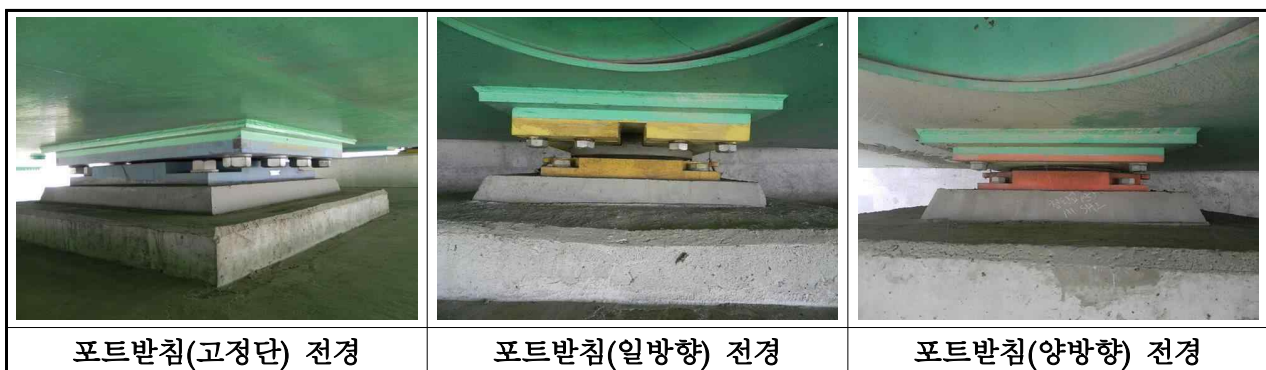
【사진 3.2.9】 교량받침 전경(대구)
