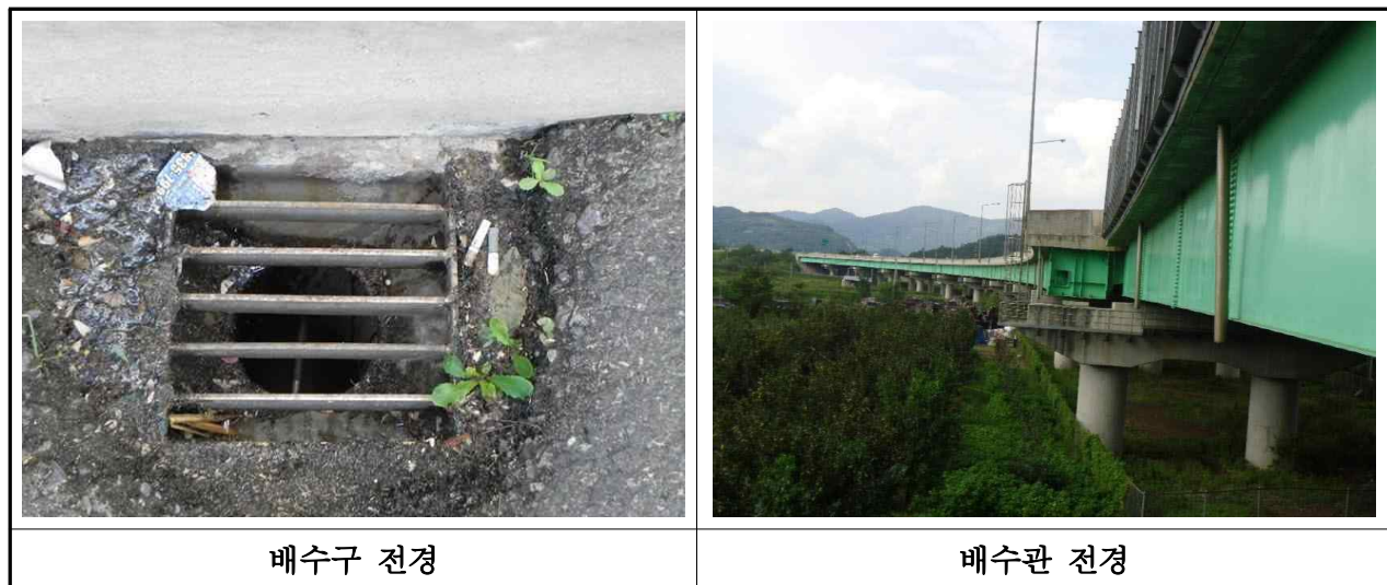
【사진 3.2.17】 배수구 및 배수관 전경(대구)
