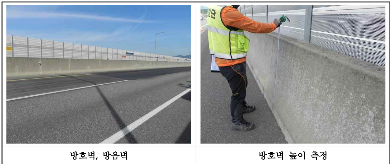
【사진 3.2.19】 난간 및 연석 전경(대구)
