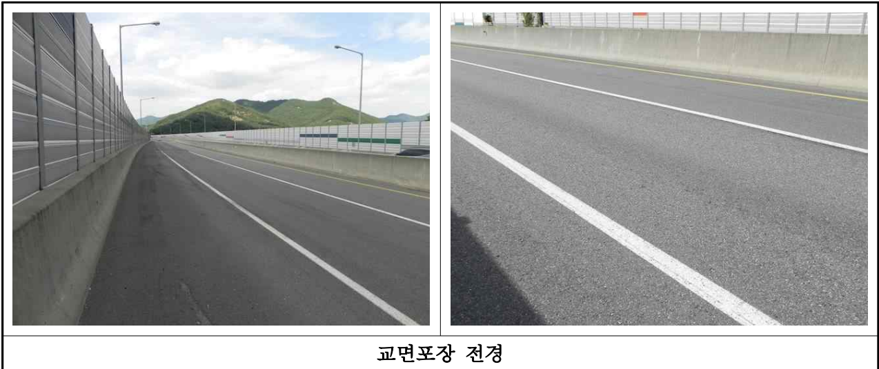
【사진 3.2.15】 교면포장 전경(대구)
