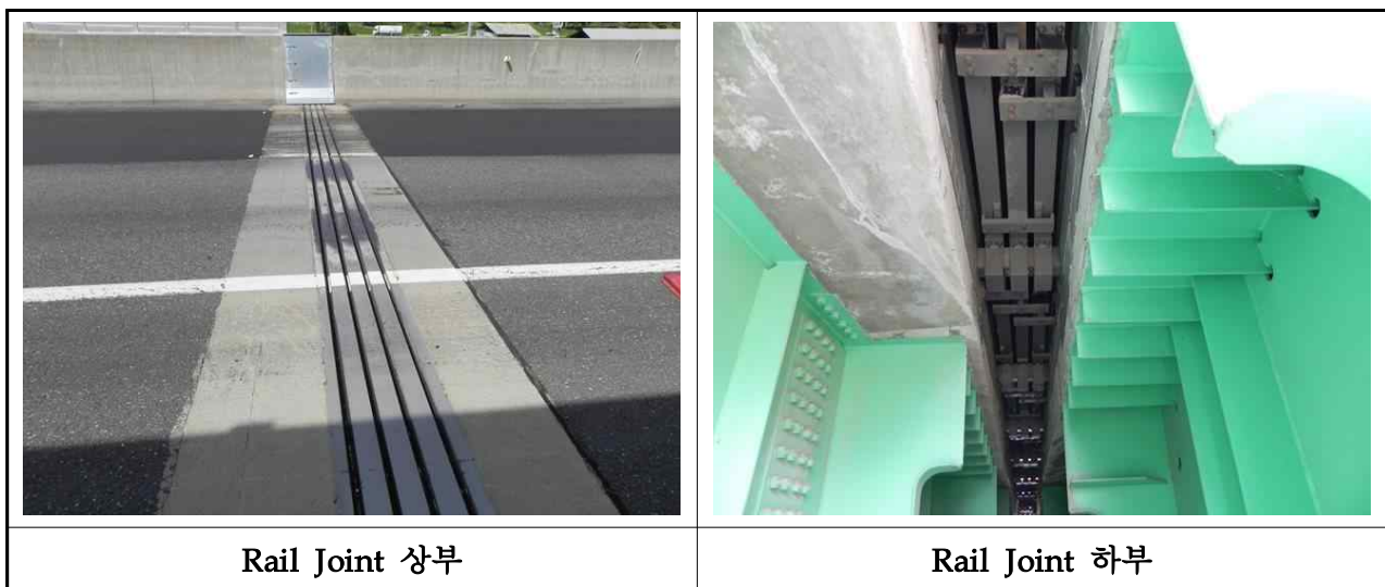
【사진 3.2.12】 신축이음장치 전경(대구)
