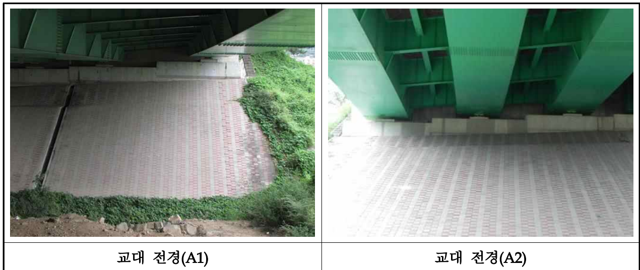
【사진 3.3.7】 교대 전경(부산)
