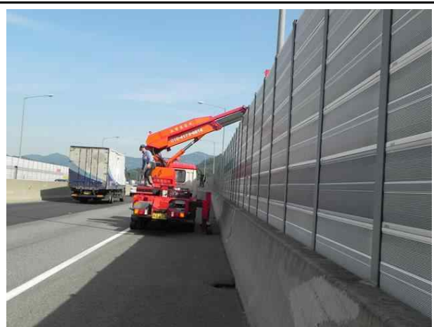
교량점검차를 이용한 조사
