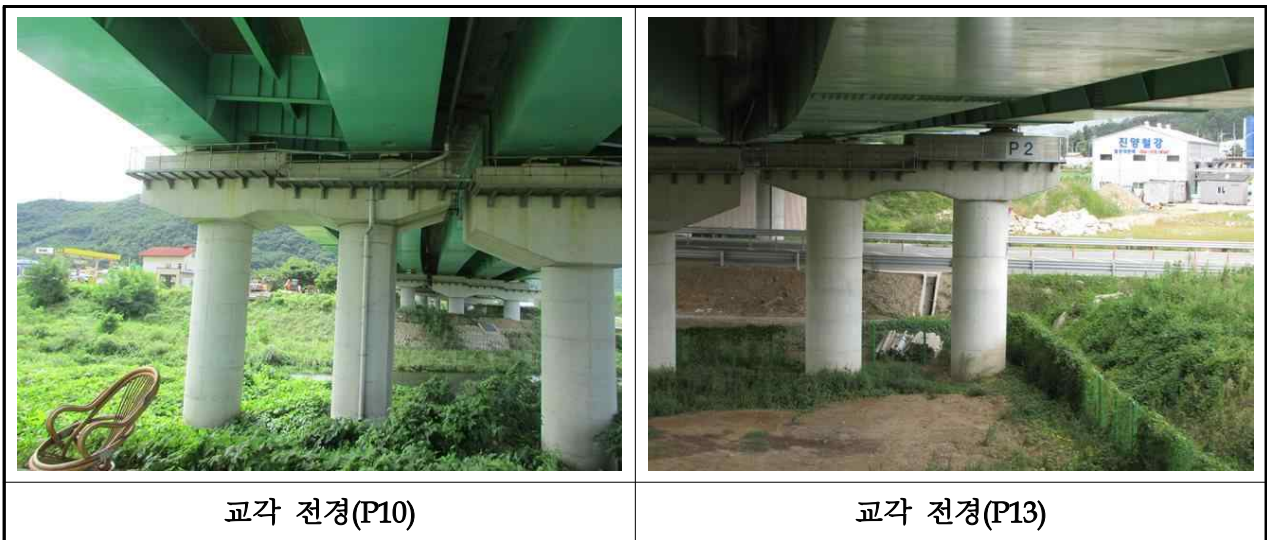
【사진 3.2.7】 교각 전경(대구)
