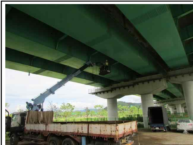
고소작업차를 이용한 조사
