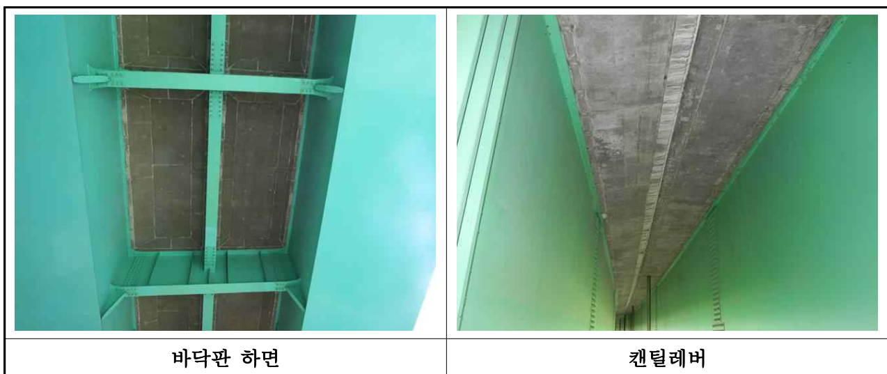
【사진 3.3.1】 바닥판 전경(부산)
