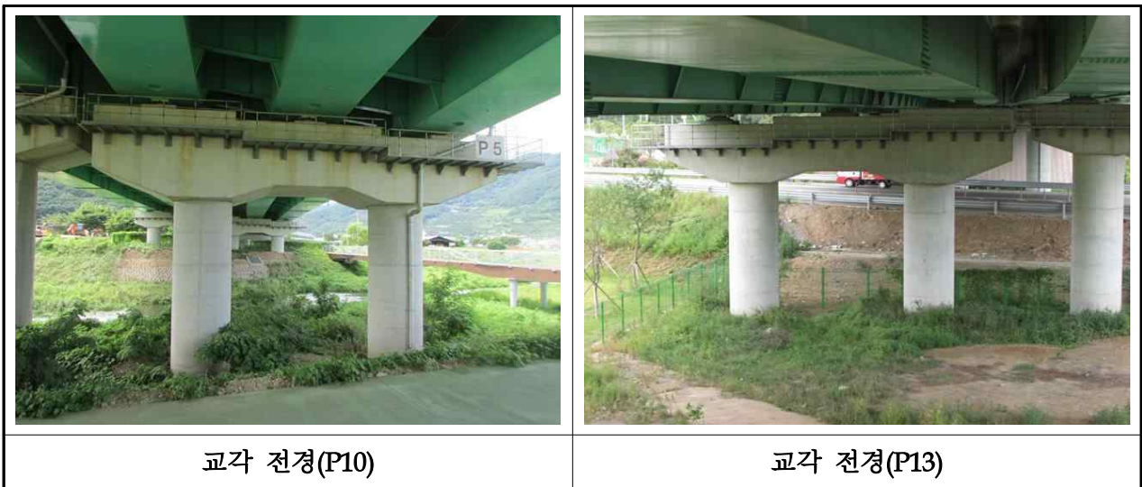
【사진 3.3.9】 교각 전경(부산)
