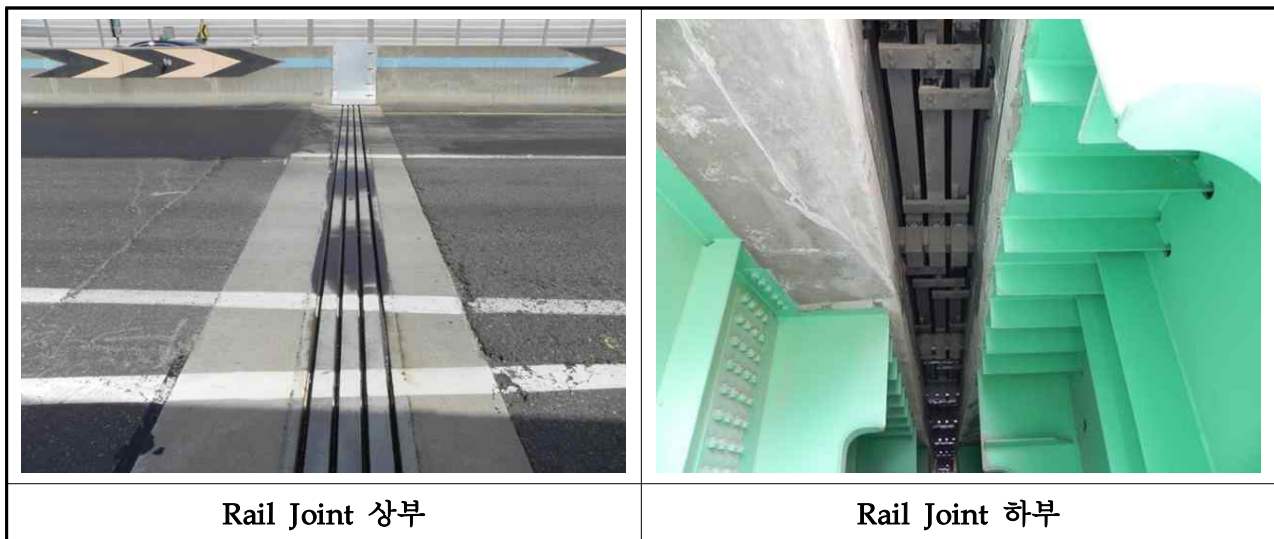
【사진 3.3.14】 신축이음장치 전경(부산)
