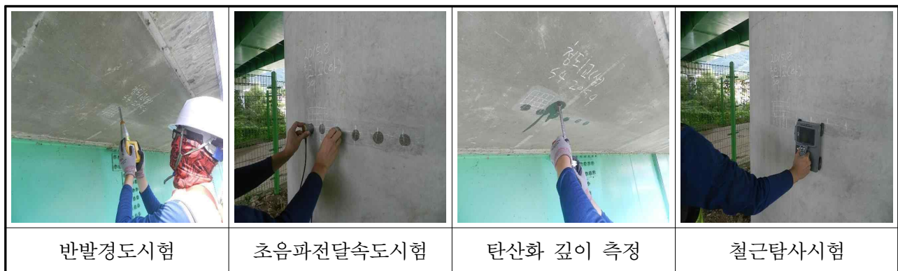
【사진 3.4.1】 콘크리트 내구성조사 전경
