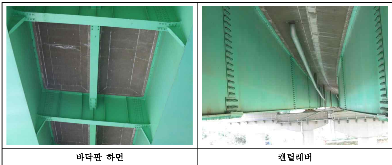
【사진 3.2.1】 바닥판 전경(대구)
