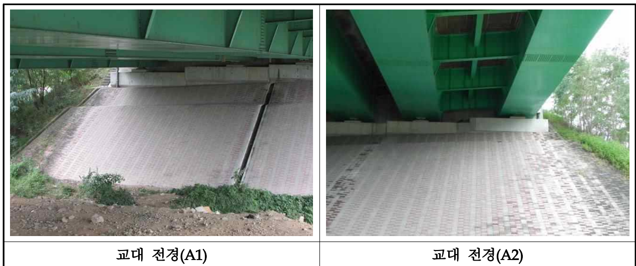
【사진 3.2.5】 교대 전경(대구)
